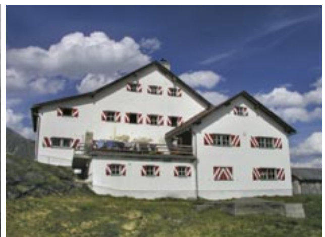
Neue Regensburger Hütte vor Erstellung des Anbaus
