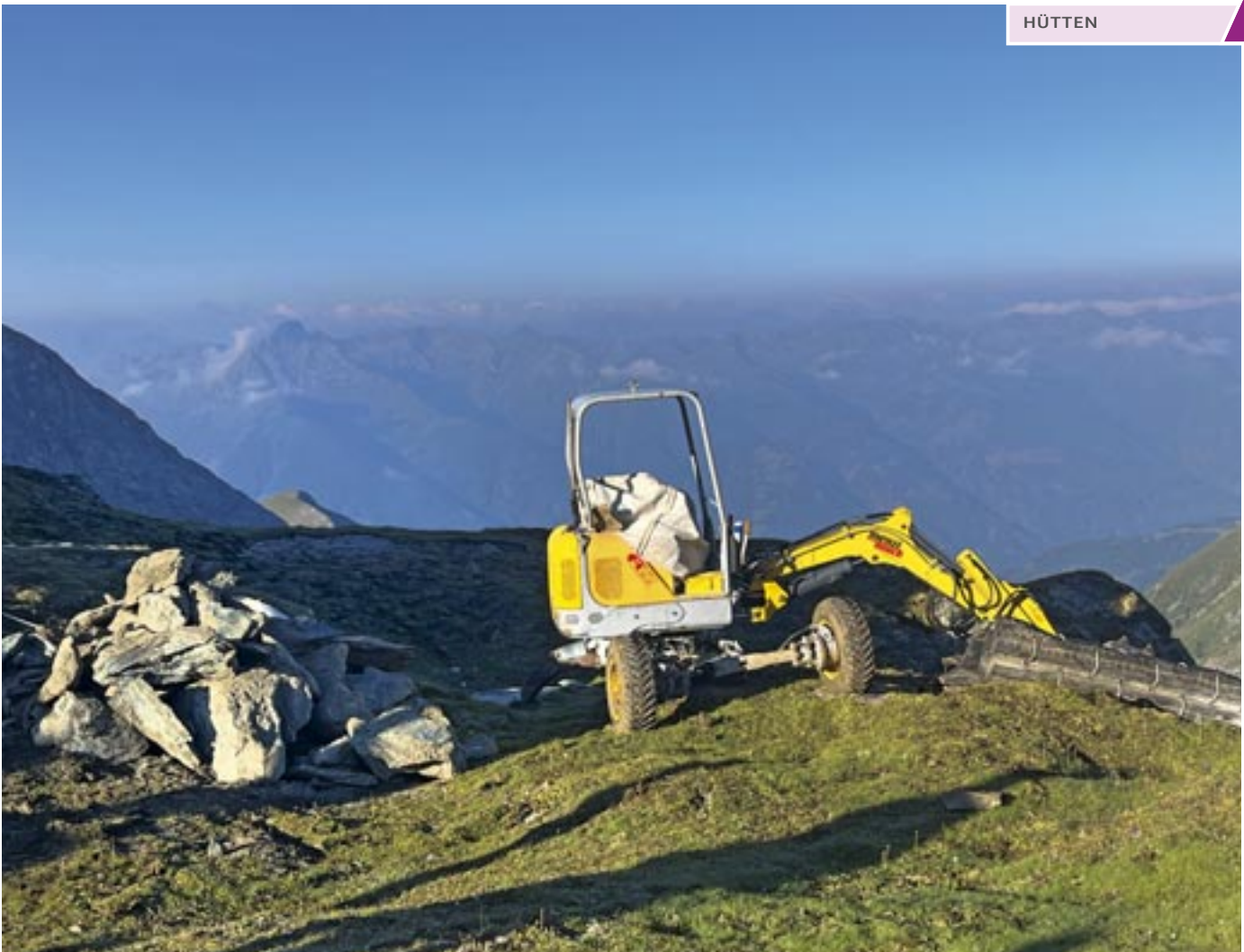
Baustelle auf 2650 Metern Höhe
