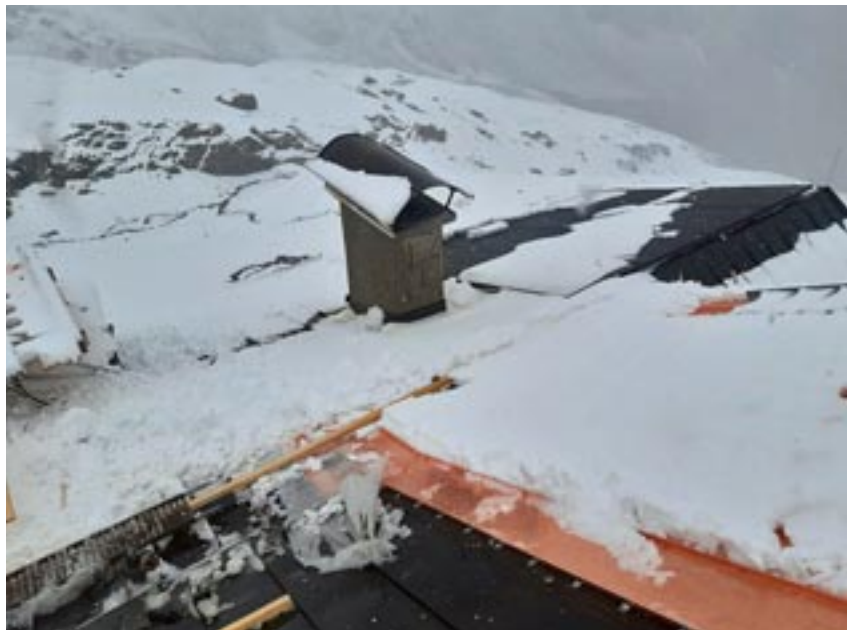
Kälte und Schnee erschweren die Installation der PV-Anlage
